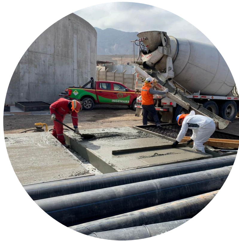
Obras de hormigón armado.
