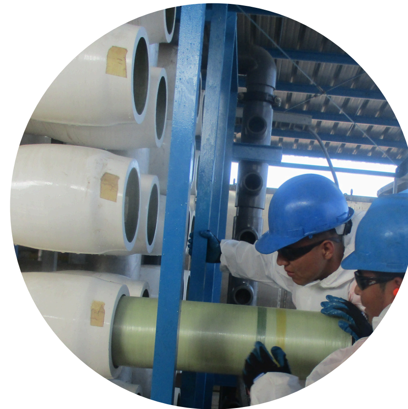
Cambios de Membrana de plantas de agua potable y residuales.
