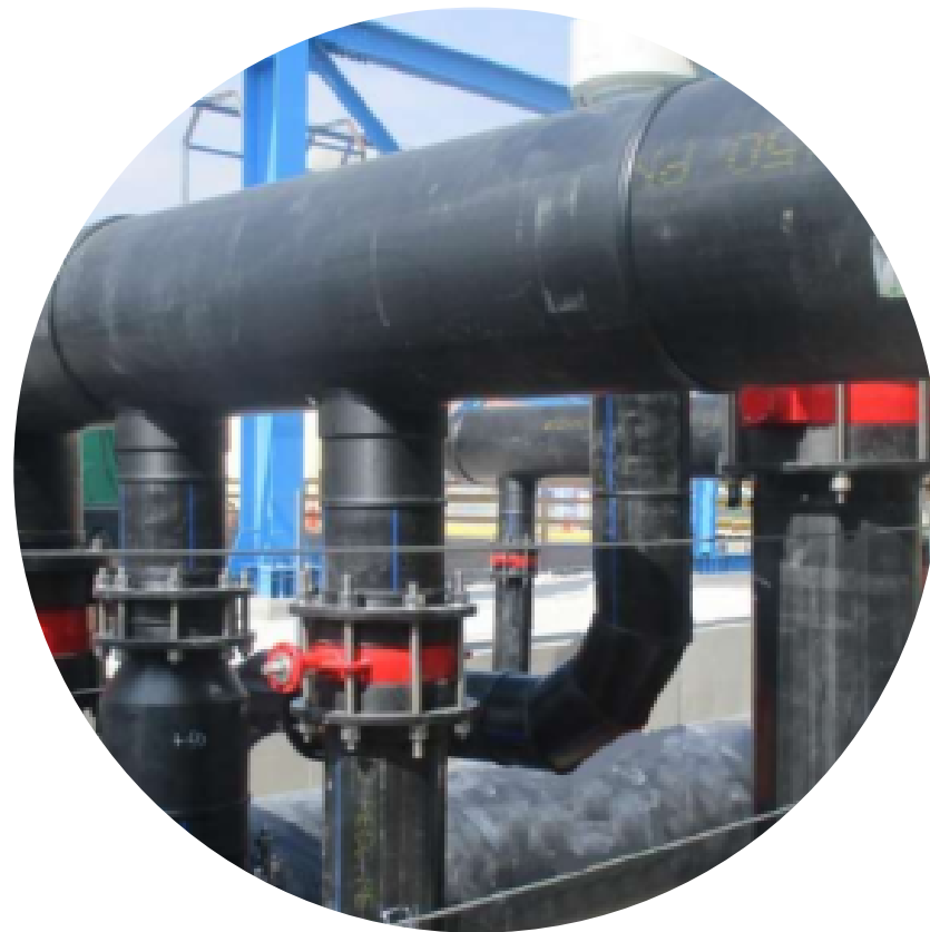
Fabricación y montaje de pieza HDPE.
