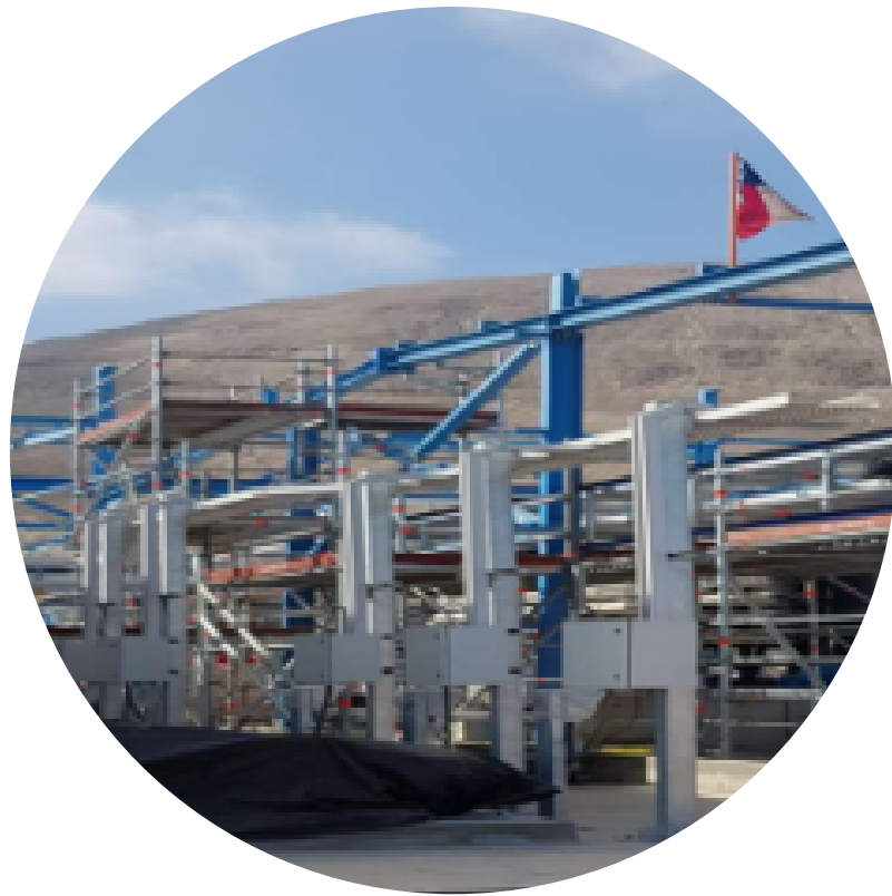
Fabricación y montaje de estructura metálica.
