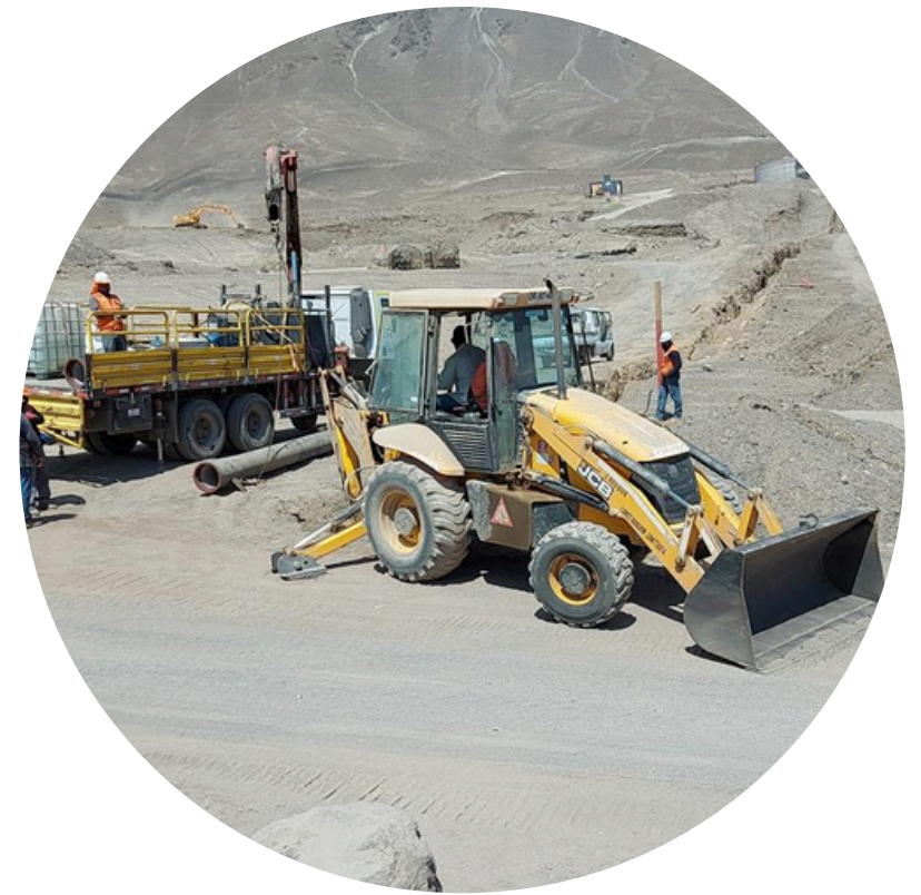
Movimiento de tierra e izajes.
