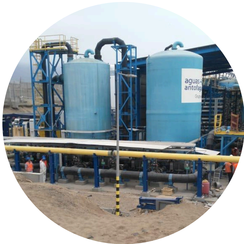
Construcción y mantención de plantas desaladoras.
