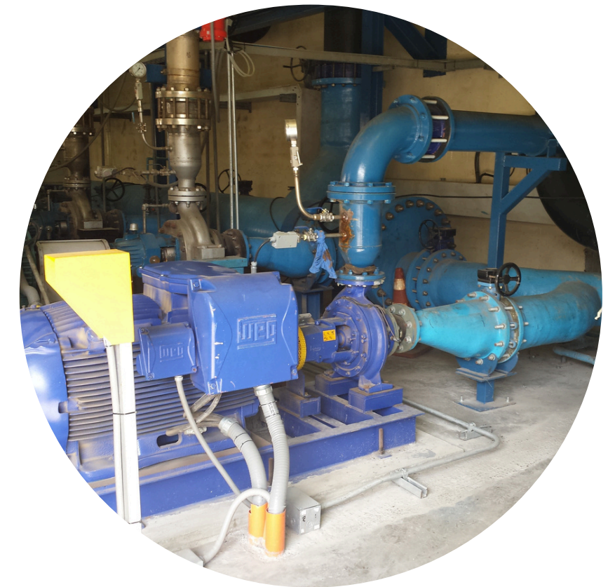
Mantenimiento y montajes de bombas de alta y baja presión.
